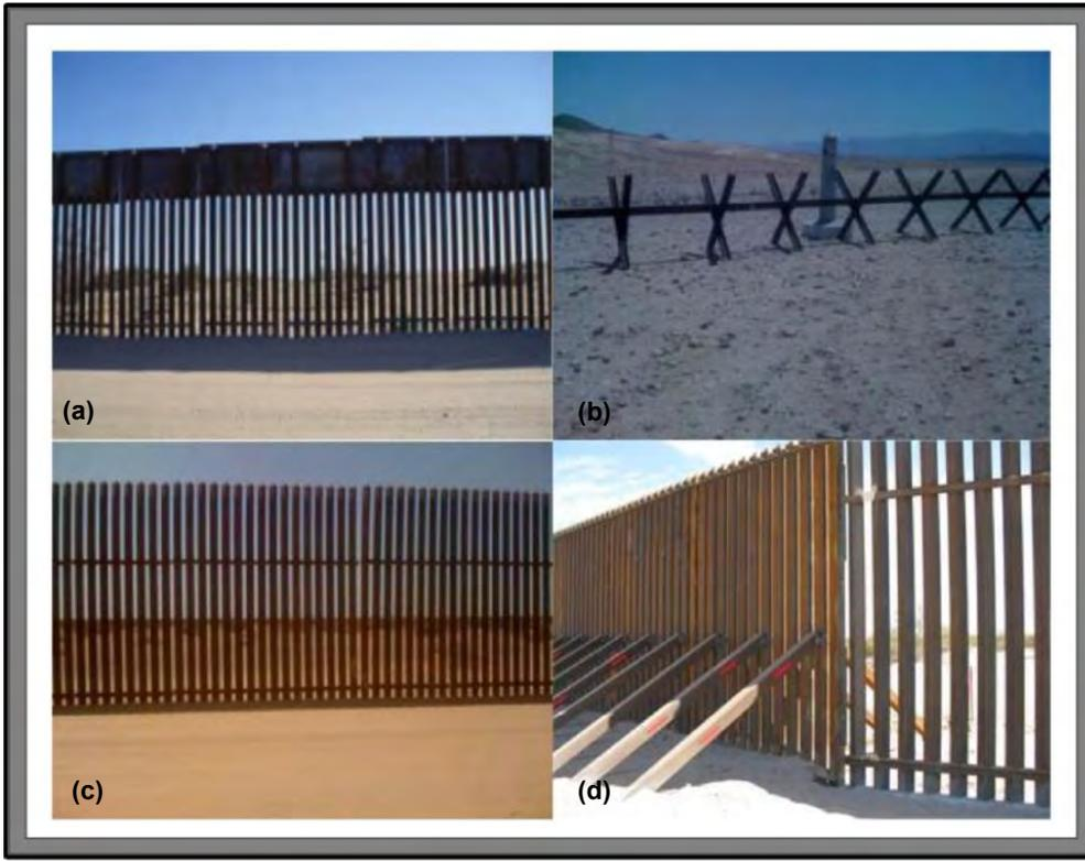
**Figure 13. Border Fence Designs: (a) PV-1, (b) VF-2, (c) P-2, (d) PV-4**
