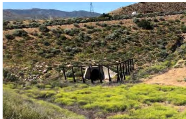
Agua Dulce Creek Culvert
